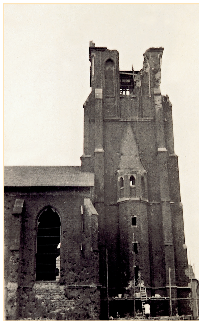
Kirche während des Wiederaufbaus 1949
